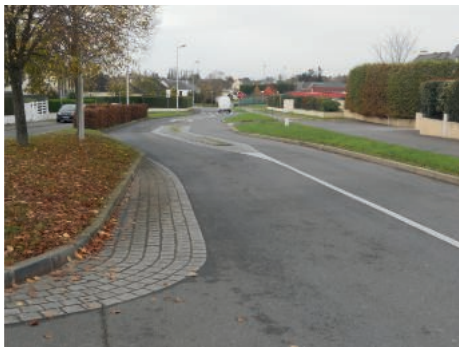
Aménagement franchissable à Servon-sur-Vilaine
